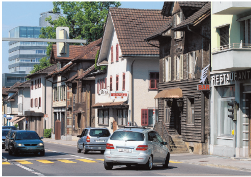
Bald liegen die ehemaligen Restaurants Falken und Rigi in Schutt und Asche. Doch davor wird noch einmal zünftig gefeiert und auf alte Zeiten angestossen.
